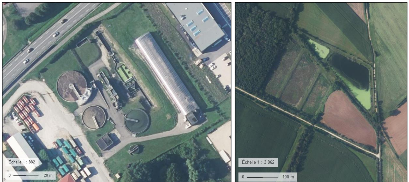
Photographie 4. Vue aérienne de la station d'épuration et de la lagune d'infiltration (Géoportail 2021)
