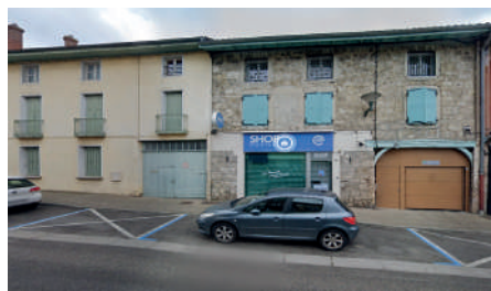
Maison de bourg, avec porche donnant accès sur le fond de parcelle. Rue de Lyon. Image google
