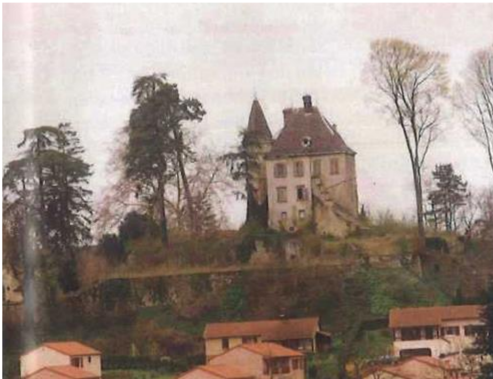
Tours Est du château avant le dernier incendie de 2011
