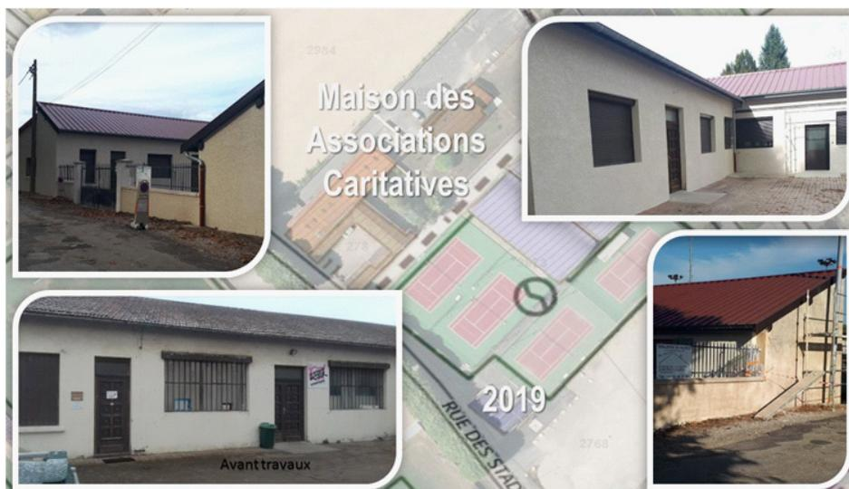
Ces travaux ont été réalisés en régie. La façade vieillissante a été rénover. L'ancien bardage bois ayant vieilli, il a été remplacé sur la façade principale et sur la façade Ouest. La partie Est a été enduite. Des reprises d'étanchéité ont également été réalisées en toiture. Ces travaux ont été exécutés par des entreprises spécialisées.
