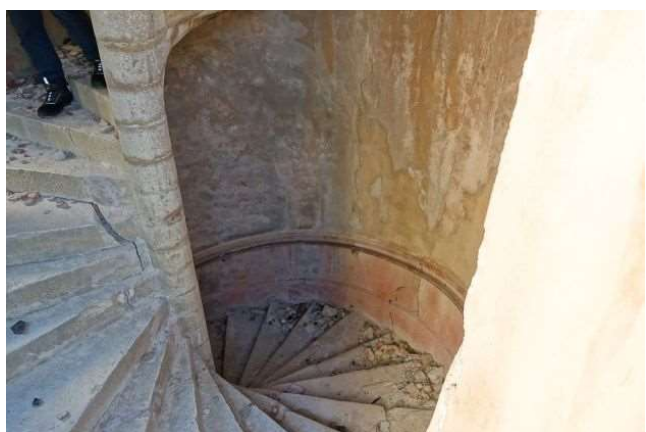
Tour hexagonale E, escalier
