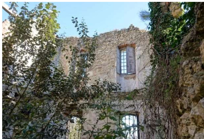
Mur E de la tour carrée E
