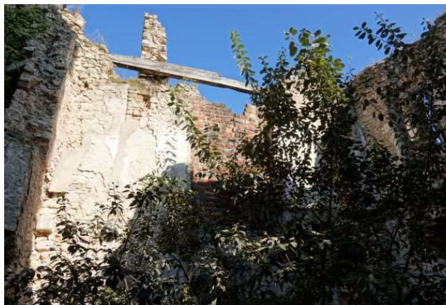
Mur de brique longitudinal séparant en deux la tour carrée E
