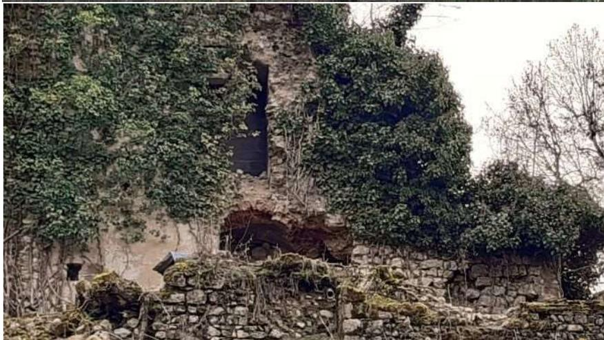
Il s'agit de **stabiliser la zone ci-dessus**, même si le trou supérieur a été déjà partiellement bouché par le précédent propriétaire (parpaings visibles de l'intérieur et de l'extérieur). La **voûte à reprendre** n'est pas en pierres, mais **en briques** : c'est ici **une ouverture et non une brèche**.
