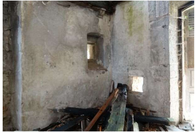
Mur renforcé séparant le local de l'intérieur du château (vu de l'intérieur du château). Au centre, petite fenêtre reliant le local et l'intérieur du château, mentionnée ci-après
