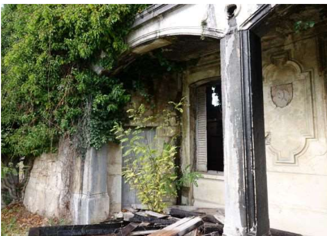
Porte du local côté E (grise, derrière arbuste)
