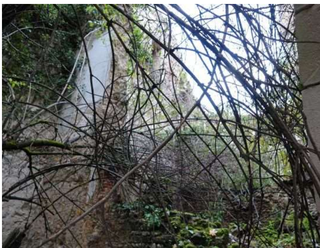
Mur transversal central vu de l'O, pan complet contre mur N
