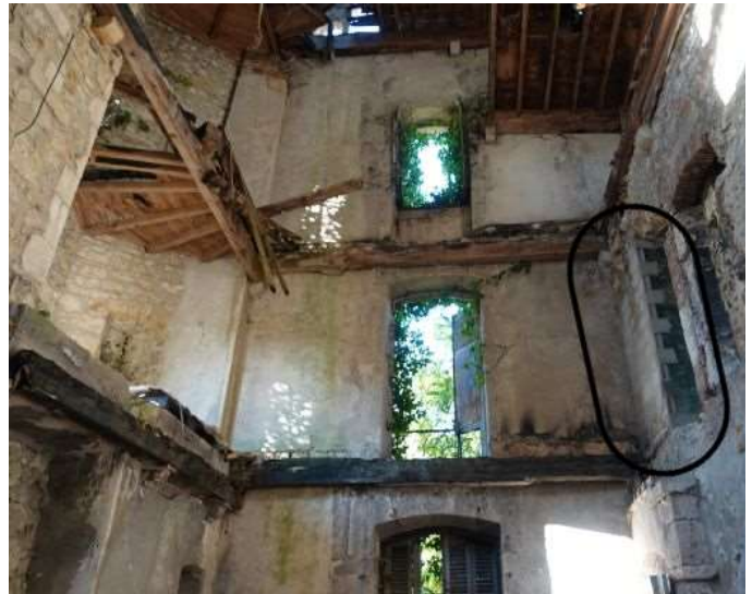
Parpaings vus de l'intérieur (à droite, à l'intérieur du marquage ovale)
