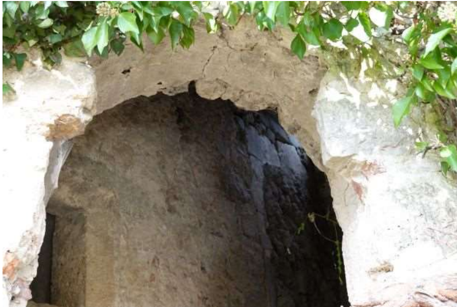
Ouverture O du local : voûte régulière, ce n'est donc pas une brèche. Les pierres ouvragées ont peut-être été retirées volontairement
