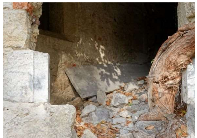
Ouverture O du local : pierre ouvragée à gauche
