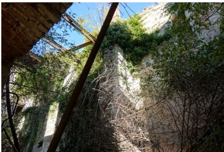
Mur transversal central vu de l'E, pan complet contre mur N
